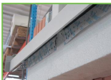
10. Jetzt kann das mit einer 5° Neigung versehene WDVS am Untergrund befestigt werden und die überstehende Einputzlochung in die Putzlage des WDVS eingearbeitet werden.
