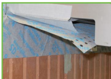
7. Silikonfolie von dem Selbstklebestreifen der Drainage-Ecke entfernen und die Drainage- Abdichtungsbahn flächig an die Ecke kleben. Hierzu kann auch ein Kleb- und Dichtstoff verwendet werden.
