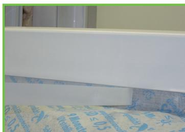
5. Die Selbstklebestreifen werden hinten von den Drainage-Ecken und von der Drainage-Abdichtungsbahn abgezogen.
