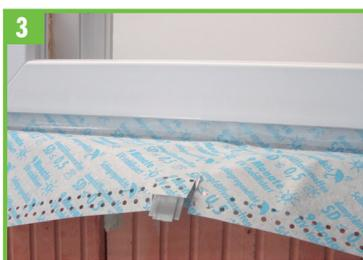
3. Die Drainage-Abdichtungsbahn wird im Bereich des Halters auf Tiefe des WDVS eingeschnitten.
