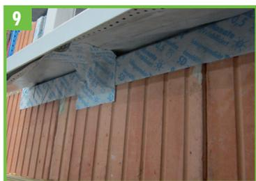
9. Die Silikonfolie von der Drainage-Abdichtungsbahn und dem Zuschnitt abziehen und den Zuschnitt Kleber in Kleber unter die Drainage-Abdichtungsbahn kleben.
