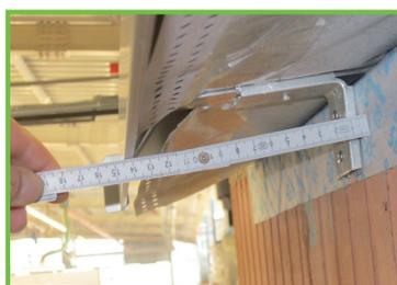
8. Einen ca. 12 cm breiten Streifen von der Drainage-Abdichtungsbahn abschneiden. Den Überstand zwischen Wand und Fensterbank nehmen und den Abschnitt entsprechend an der Selbstklebeseite kürzen. Die Einputzlochung sollte erhalten bleiben, damit sie der WDVS Monteur in den Unterputz einarbeiten kann.
