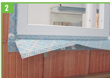
2. Die Drainage-Abdichtungsbahn wird mit dem Selbstklebestreifen am Fensterstock befestigt.
