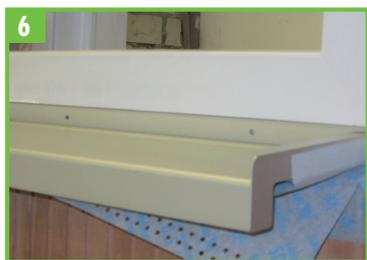
6. Die Fensterbank wird in den Halter eingeschoben und am Fensterstock befestigt. In einigen Fällen verlangt der Auftraggeber zusätzlich ein vorkomprimiertes Dichtband zwischen Fensterstock und Fensterbank. Dieses muss gegebenenfalls zusätzlich angebracht werden.
