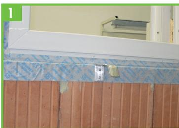
1. Der Fensterbankhalter wird nach Herstellerangaben am Mauerwerk befestigt. Wir empfehlen grundsätzlich Systemhalter zu nutzen, da sie den notwendigen Freiraum zum Einbringen der Drainage-Abdichtungsbahn gewähren.
