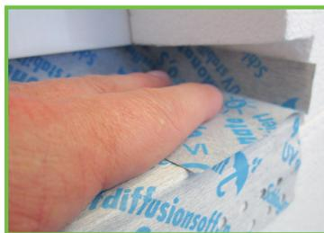
4. KONTEX® Drainage-Ecken ablängen. Die Ecke von unten und die Eckenrücken von hinten mit ausreichend Dichtstoff ausrüsten.
