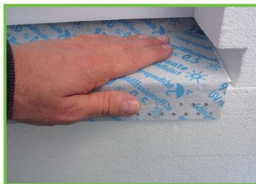
3. Den unteren 60 mm Power- Haftklebestreifen freilegen und die KONTEX® Drainage-Abdichtungsbahn in endgültiger Position fixieren.
