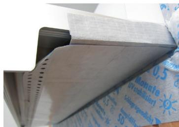
6. Die Fensterbank mit aufgebrachtem KONTEX® Drainage-System nun wie gewohnt montieren.
