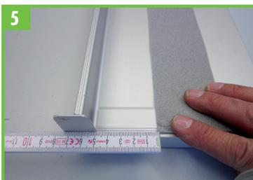
5. Unter der Fensterbank das KONTEX® Drainage-Entkopplungsband ca. 1cm von der Fassade zurückspringend aufkleben.
