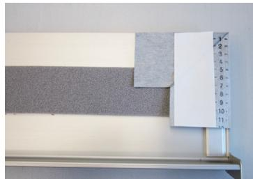
2. Die KONTEX® Drainage-Ecken entsprechend der Ausladung vom Fensterstock bis Ende Fassadendämmung ablängen. Kleberabdeckung des 20 mm Selbstklebestreifens an der kurzen, inneren Seite der Ecke entfernen und Ecken rechts und links der Fensterbank verkleben.
