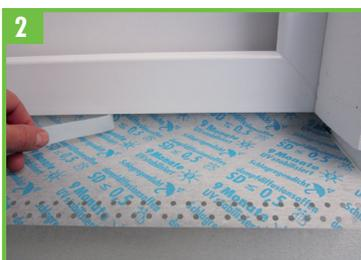
2. Die KONTEX® Drainage-Abdichtungsbahn gerade ausrichten und mit hinterem 20mm Selbstklebestreifen am Fensterstock anbringen.
