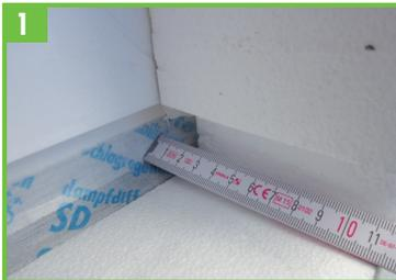
1. Die Lage des KONTEX® Drainage-Systems vom Fensterstock bis Außenkante Fassadendämmung einmessen.
